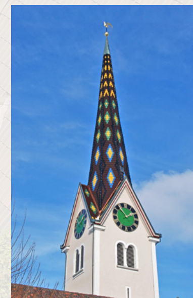
Sonderanfertigung Castello, Kirche Affeltrangen Schweiz
